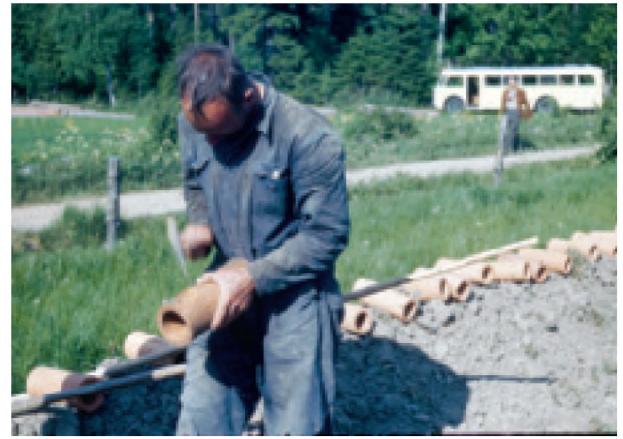
FIGUR 2b. Drængrøft med drænrør, der er parat til at blive lagt i jorden.
