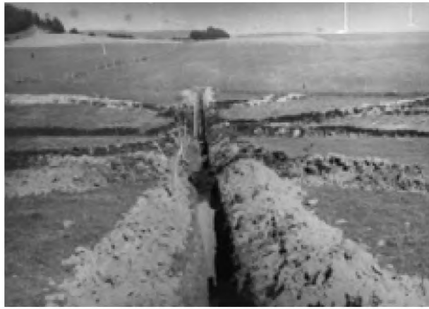
FIGUR 2a. Drængrøfter gravet for afvanding af en mark.
